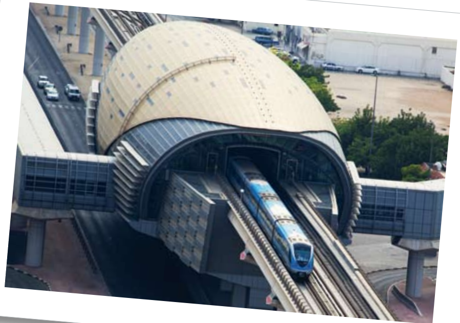
Die hochmoderne Metro wird fahrerlos betrieben; die Bahnhöfe sind klimatisiert.
